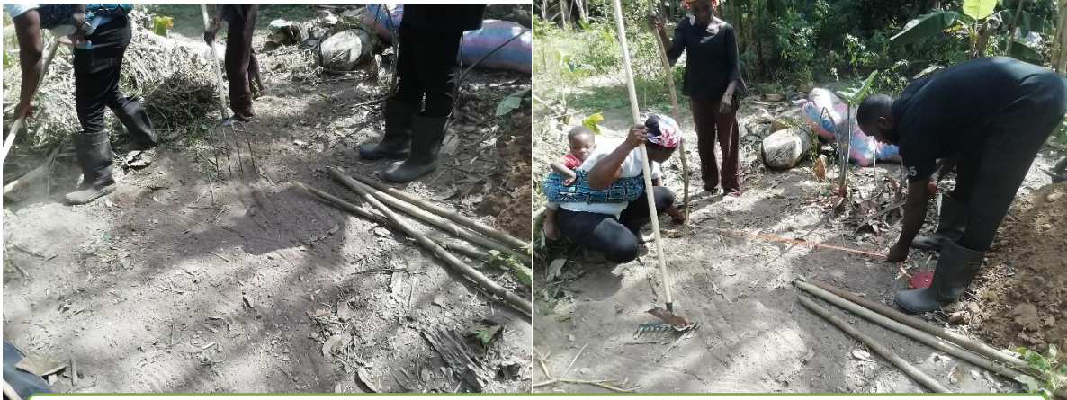
Préparation du site
